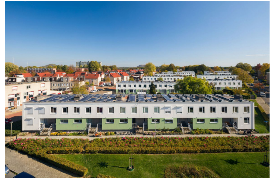
Verstedelijking als één van de leidende transitieopgaven in Rolduckerveld, Kerkrade Foto: Kernarchitecten
